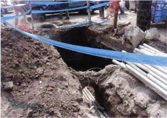
Excavación de Pozo
