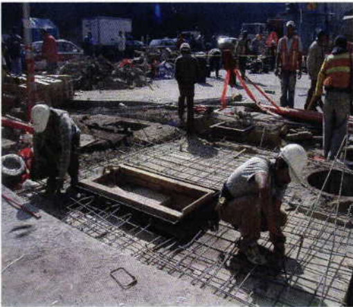
Reposición de Concreto
