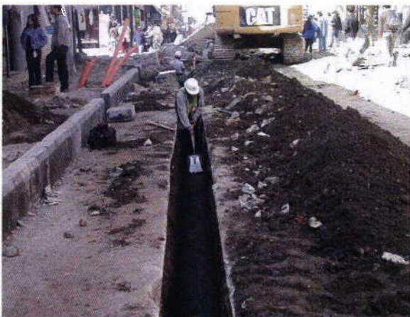
Relleno de Tepetate
