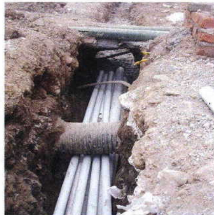
Colocación de Ductos
