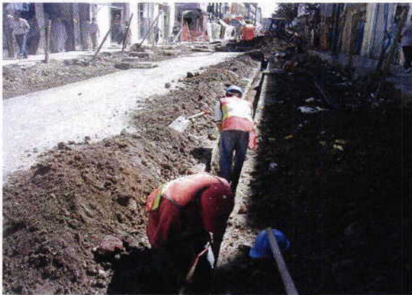
Excavación de Canalización
