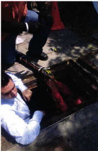
Personal de TELMEX trabajando en Pozo
