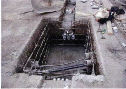
Pozo listo para Colado
