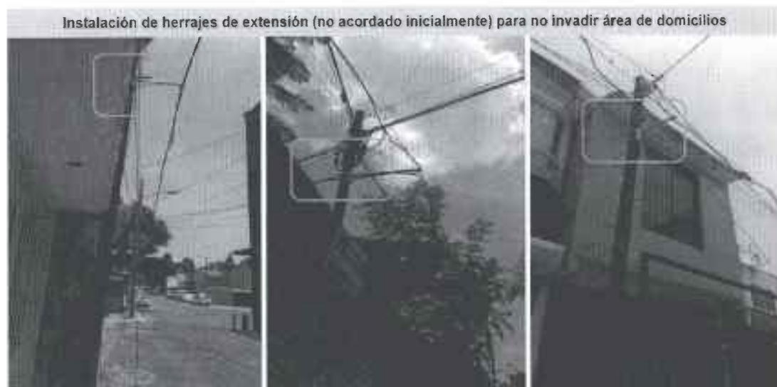
Figura 5.4: Evidencia de instalación de herrajes de extensión [Fuente: Grupo Televisa, 2020]
