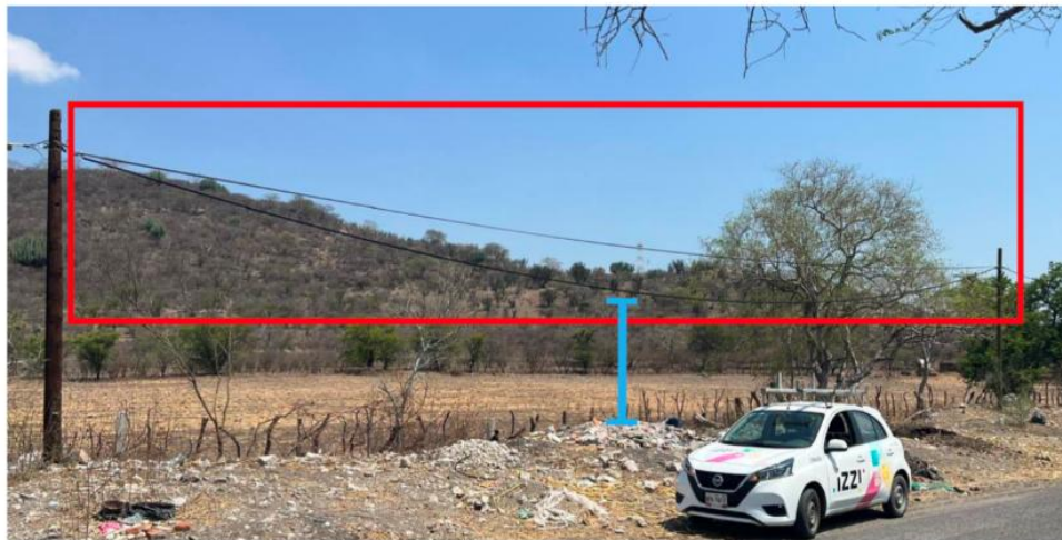
Figura 3.3: Infraestructura sin mantenimiento que el AEPT ofrece a través de la ORCI EM (3/3) [Fuente: Elaboración propia, 2025]
